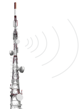
Antenne trasmittenti direzione A
