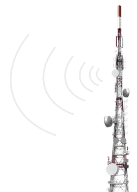
Antenne trasmittenti direzione B
